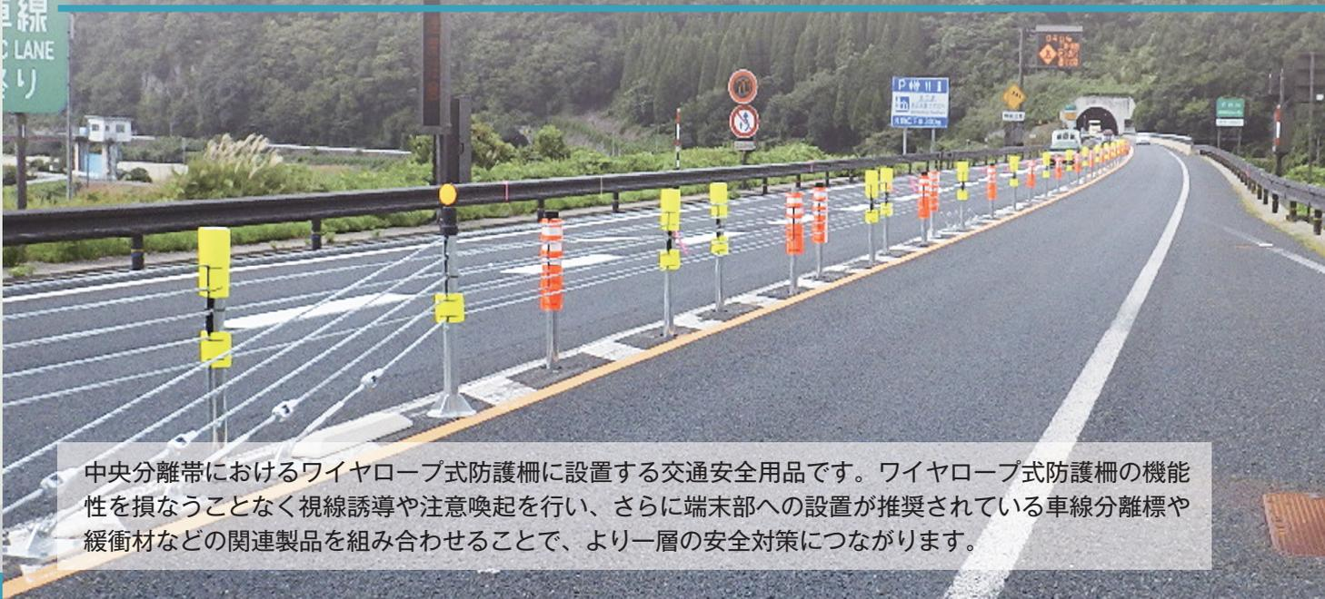
中央分離帯におけるワイヤロープ式防護柵に設置する交通安全用品です。ワイヤロープ式防護柵の機能性を損なうことなく視線誘導や注意喚起を行い、さらに端末部への設置が推奨されている車線分離標や緩衝材などの関連製品を組み合わせることで、より一層の安全対策につながります。
